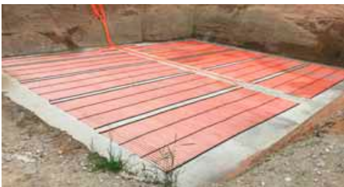
Ansicht: Erdspeicher unter der Bodenplatte
